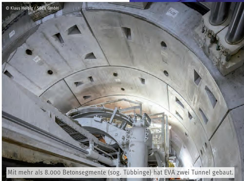
Mit mehr als 8.000 Betonsegmente (sog. Tübbinge) hat EVA zwei Tunnel gebaut.
